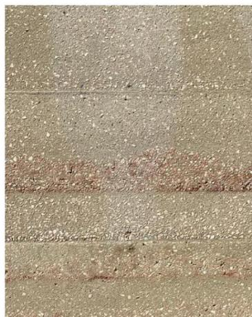
Béton avec agrégats de briques - coulé par passes
